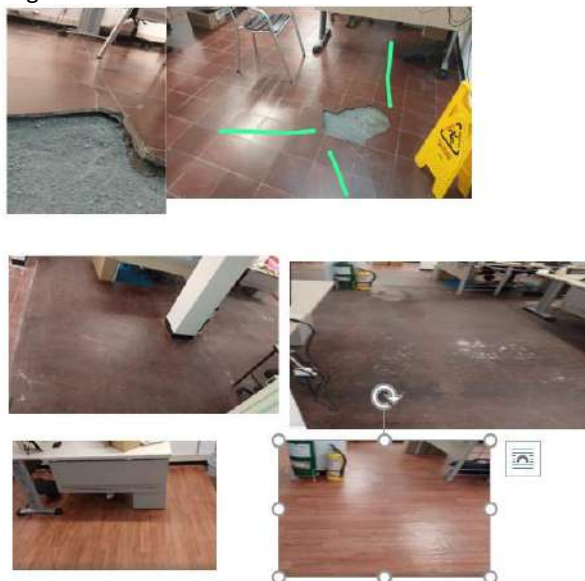
Ilustración 237. Registro Fotográfico de Remodelación del Piso de la Oficina de Archivo
